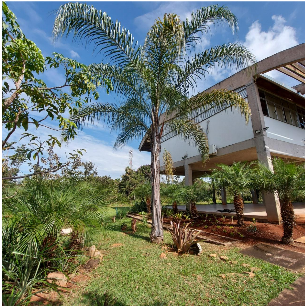
Fachada lateral do CRAD
